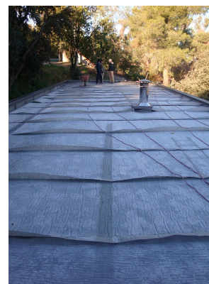
Une couche drainante en géocomposite, avec deux couches de filtrage anti-racines .
