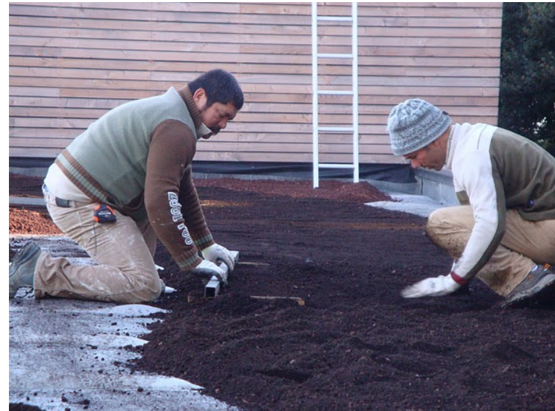
6 cm d'un mélange 50% pouzzolane, 50% terreau, tirés à la règle comme une dalle maçonnée ! Entre les surfaces à cultiver, de la pouzzolane un peu plus rouge
