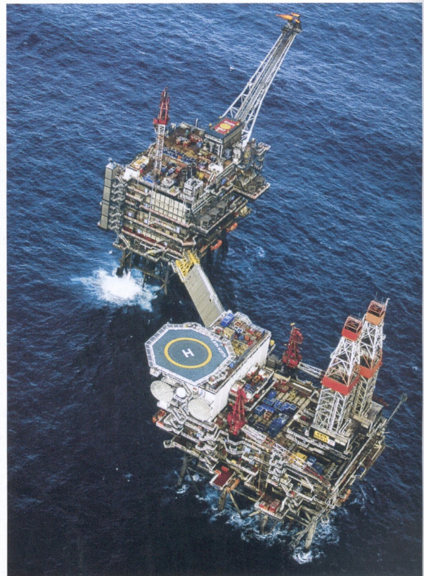
3 Plate-forme pétrolière en mer du Nord
